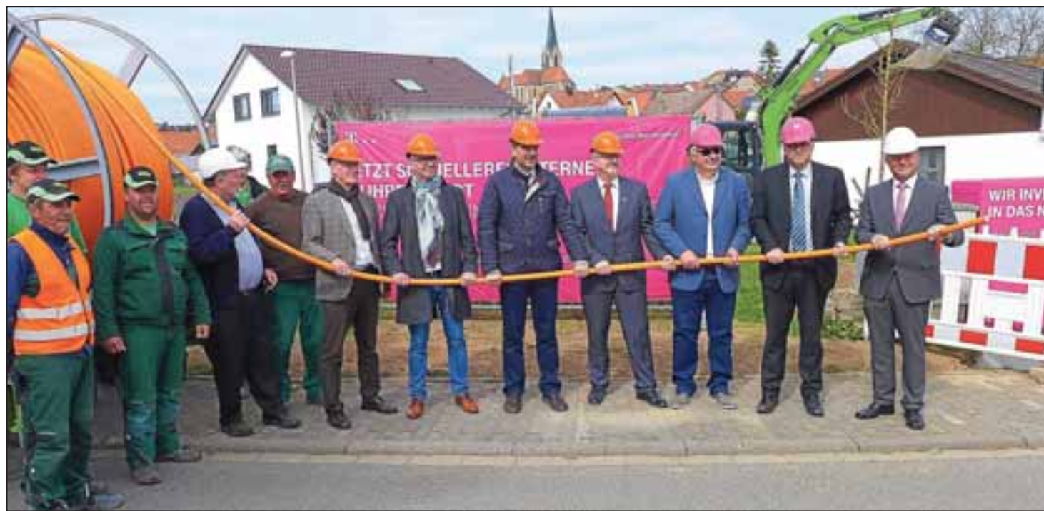
Kein Spatenstich, sondern ein Gemeinsam-an-einem-Strang-ziehen: In Höpfingen wurde gestern offiziell das Ausbaugelände 6 im Rahmen des kreisweiten Breitbandprojekts gestartet. Foto: Wendelin Böhler
